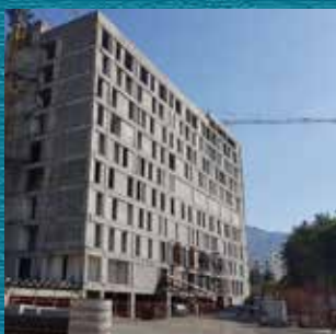
مرکز جامع سرطان در حال ساخت است
